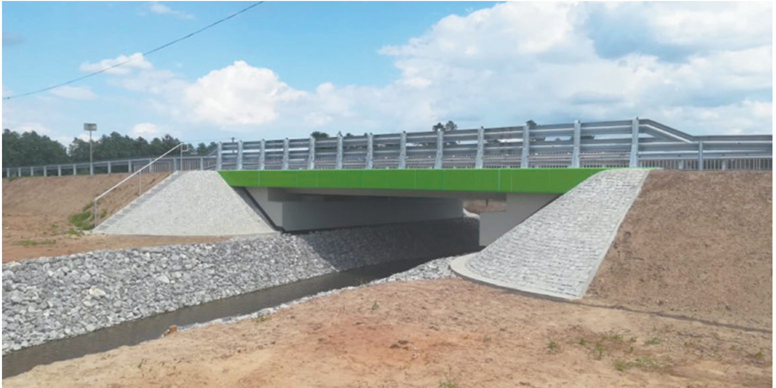
Przebudowa mostu w Kurach (gmina Tłuszcz), Koszt zadania: 2 545 222,27 zł
