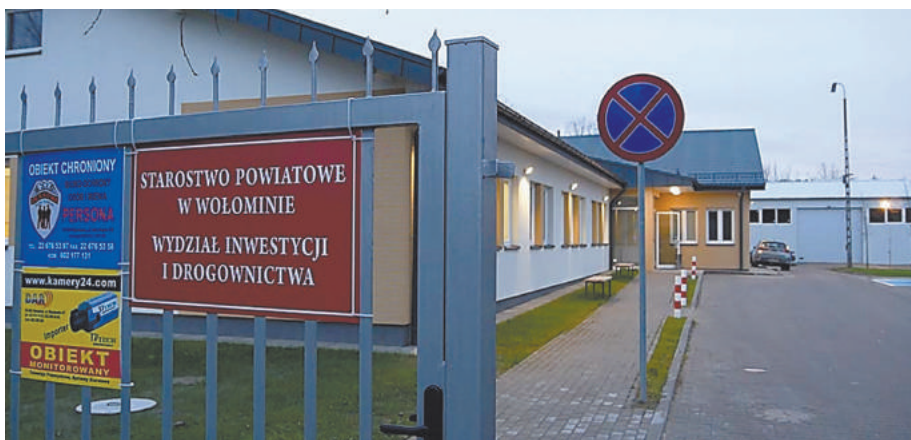
Budowa bazy dla Wydziału Inwestycji i Drogownictwa w Zagościńcu (gm. Wołomin) Koszt zadania w 2017 roku 2 499 633,70 zł. Koszt całkowity: 3 515 433,38 zł.
